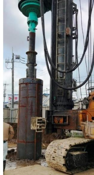
掘削先端から受ける力(ずれる力)を掘削孔壁へ効率よく分散し、全周面より反力を得るケーシング付き掘削機材
